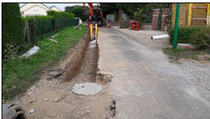
Terrassement pour pose d'un réseau gravitaire
