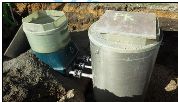
Pose d'un poste de refoulement
