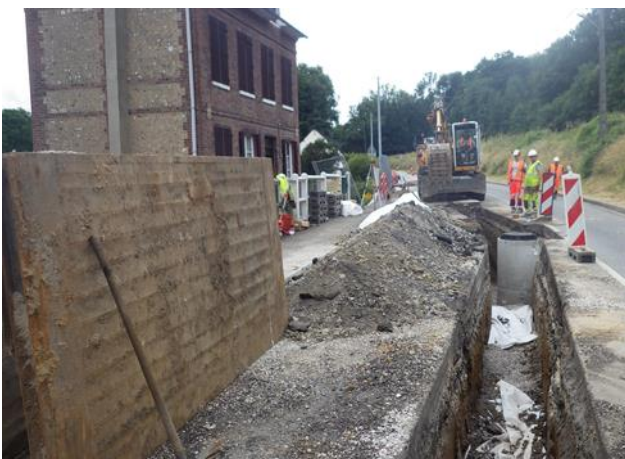
Tranchée pour pose de canalisation en fonte avec regard
