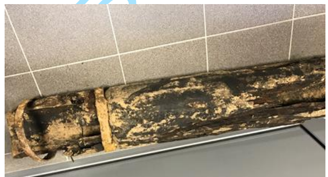
Découverte sur le chantier d'une ancienne canalisation en bois cerclée de fer
