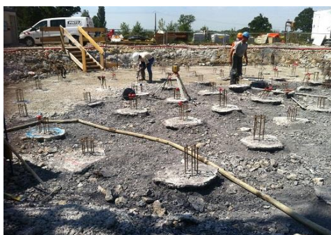
Réalisation des fondations Recépage des micropieux
