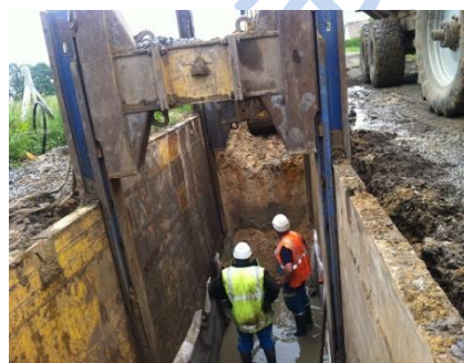
Pose de la conduite d'arrivée Tranchée sur blindage glissant
