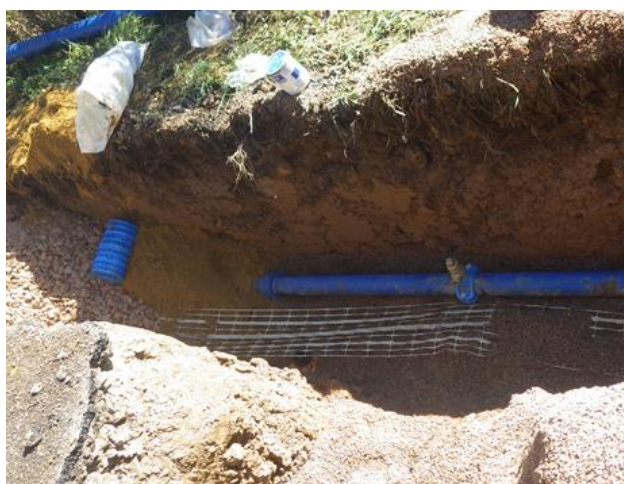
Pose de la canalisation d'eau potable
