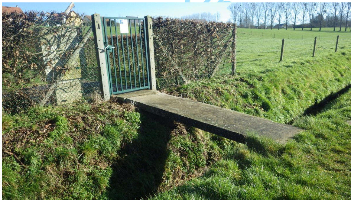
Entrée de la STEP d'Etampuis à aménager en plateforme de stationnement pour les véhicules
