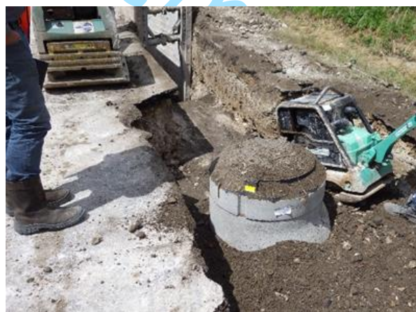
Compactage autours d'un regard de visite
