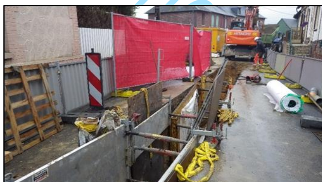
Dépose d'un réseau d'amiante
