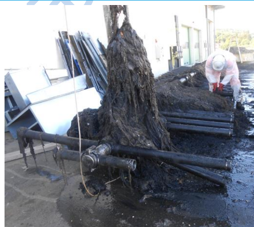
Nettoyage et remise en état d'une rampe d'aération
