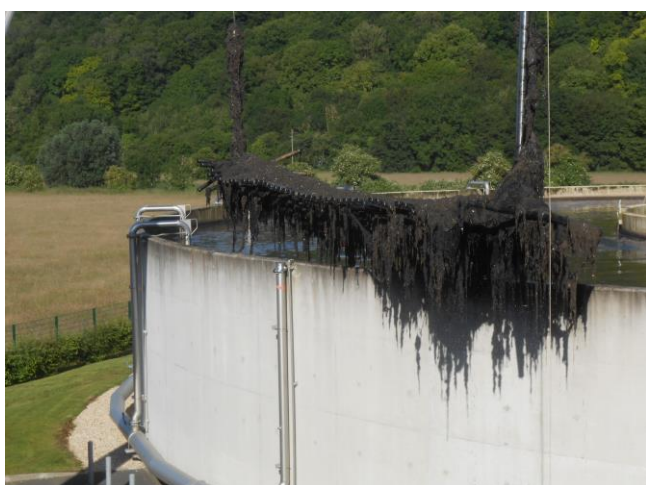
Sortie de la 1 ère rampe d'aération
