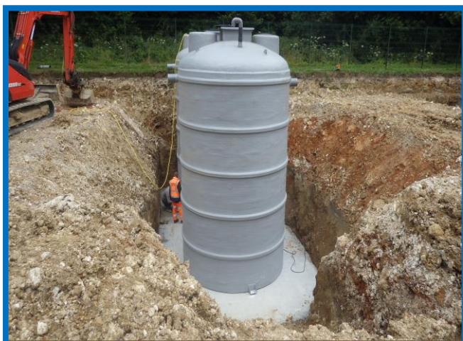
Mise en place d'un décanteur-digesteur
